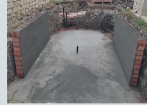
2. Altyapı zemin betonunun atılması ve yan duvarların yapılması
