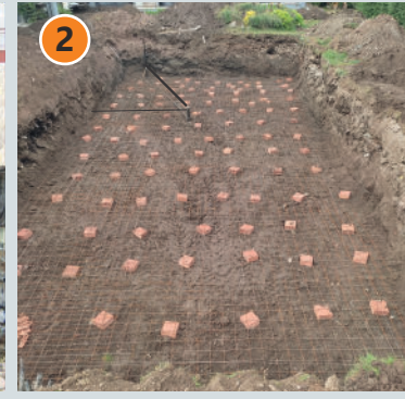
Havuz projesine uygun demirleme, borulama ve kodlama işlemi yapılması
