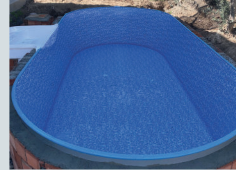
4. Her parça antibakteriyel PVC liner ile havuzun kaplanması
