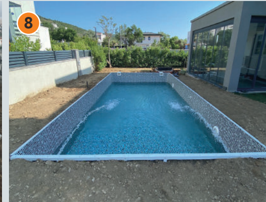
Antibakteriyel PVC Liner ile havuzun kaplanması
