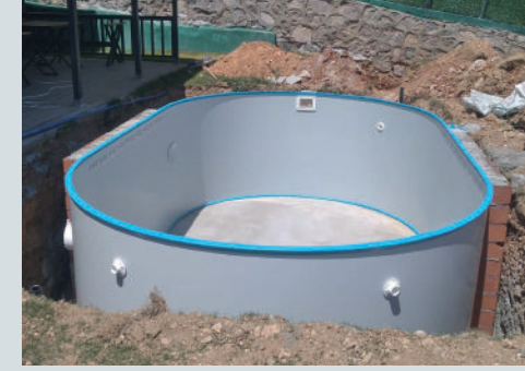
3. Havuz projesine uygun çelik gövde montajının yapılması.
