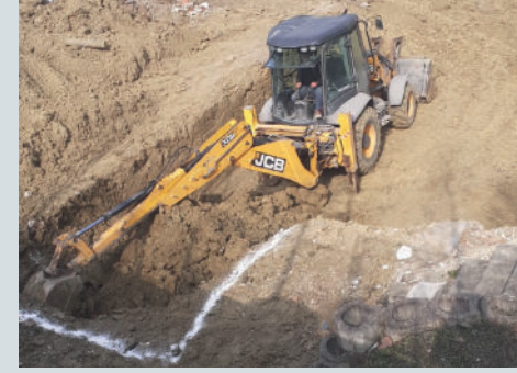
1. Havuz projesine uygun hafriyatın alınması ve atılması
