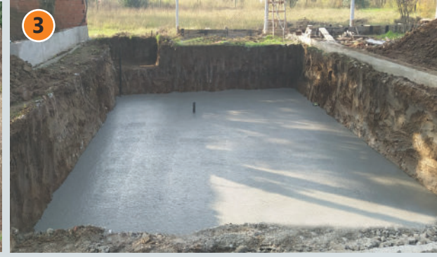
Havuz projesine uygun altyapı zemin betonu atılması
