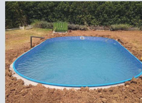
7. Havuz projesine uygun havuz çevresinin dolgu işleminin yapılması
