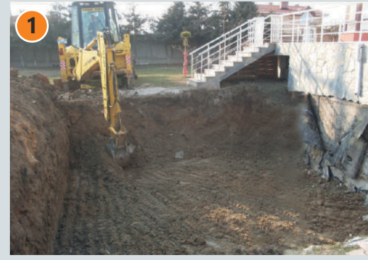
Havuz projesine uygun hafriyatın alınması ve atılması
