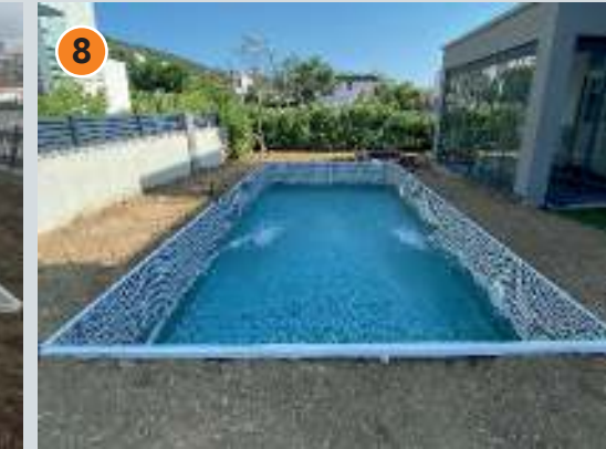
Antibakteriyel PVC Liner ile havuzun kaplanması
