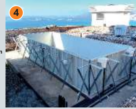
Havuz projesine uygun altyapı zemin betonu atılması
