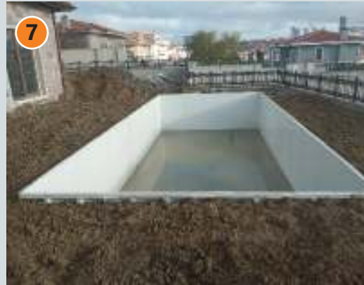
Havuz projesine uygun havuz çevresinin dolgu işleminin yapılması
