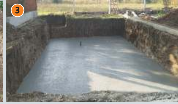
Havuz projesine uygun altyapı zemin betonu atılması
