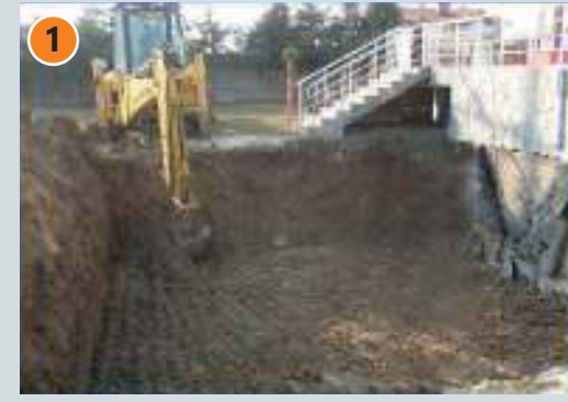
Havuz projesine uygun hafriyatın alınması ve atılması
