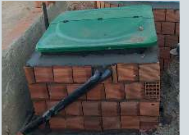
Makina dairesinin yerinin hazırlanması ve makine dairesinin çevresinin korumaya alınması
