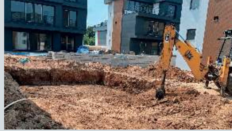
Havuz projesine uygun harfiyatın alınması ve atılması
