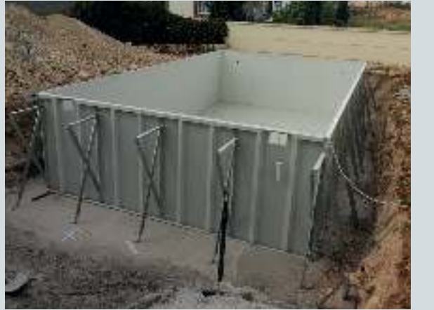
Havuz projesine uygun olarak panellerin montajı
