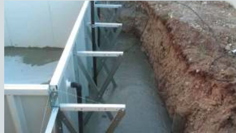
Havuz projesine uygun panel desteklerine beton dökülmesi.
