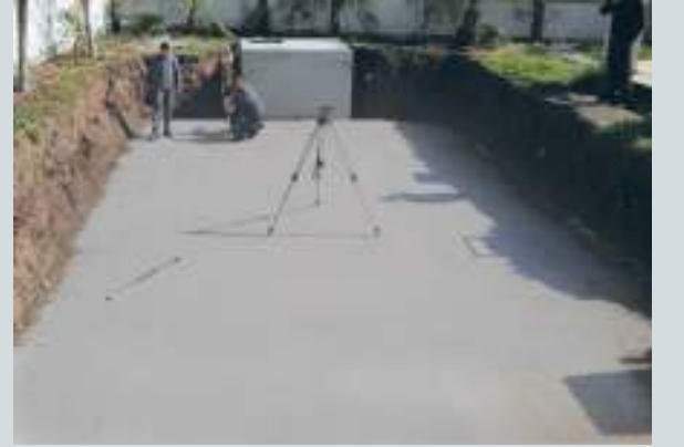
Havuz projesine uygun altyapı zemin betnu atılması
