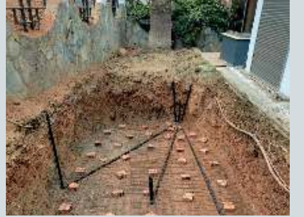
Havuz projesine uygun harfiyatın atılması
